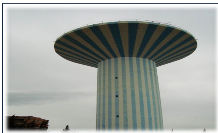
Figure II.14 : Vue générale du château d'eau 2000m 3 CPR. [82]
