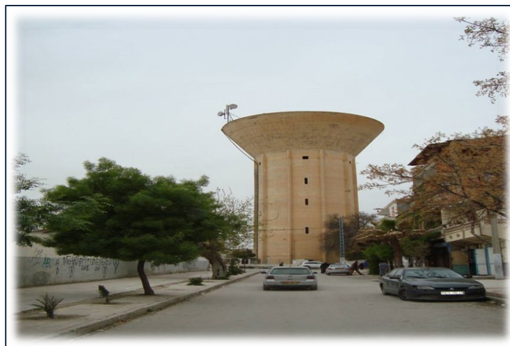
Figure II.11 : Vue générale du réservoir 2000m 3 Boulevard Bounaas. [82]
