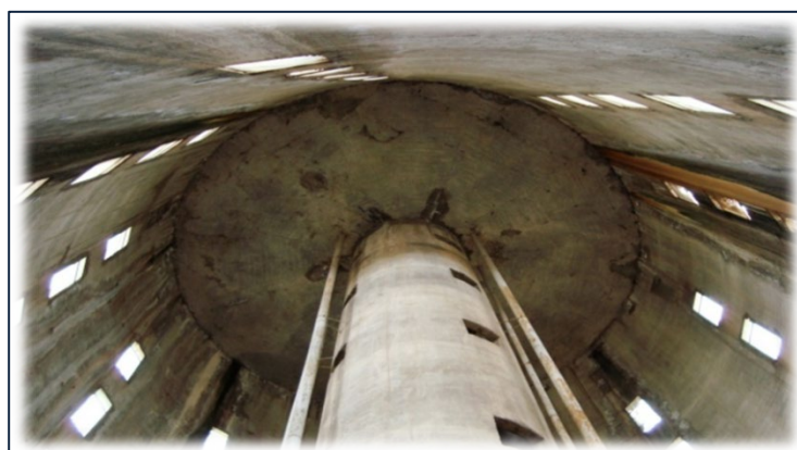
Figure II.18 : Joint entre la cuve et la tour. [82]
