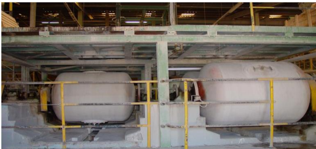
Figure II.17 : Les moulins à tambour pour la préparation de l'émail et l'engobe
