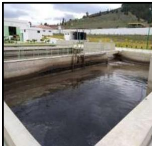
Figure 16 : zone anoxie amont du bassin biologique (STEP, Sidi Merouane).
