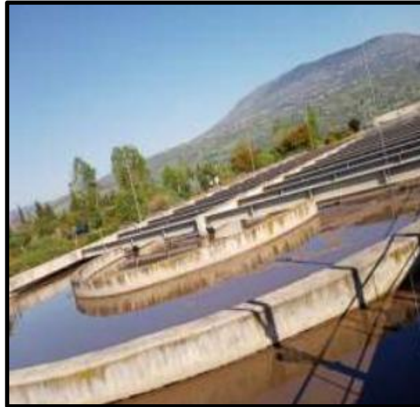
Figure 15 : Bassin biologique (STEP, Sidi Merouane).
