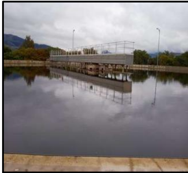
Figure 20 : Clarificateur (STEP, Sidi Merouane).
