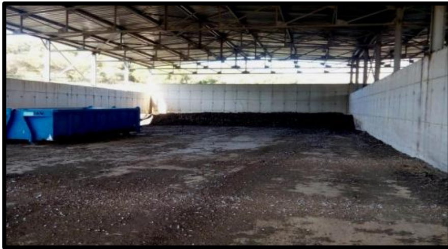
Figure 25 : Aire de stockage des boues séchées (photo personnelle).
