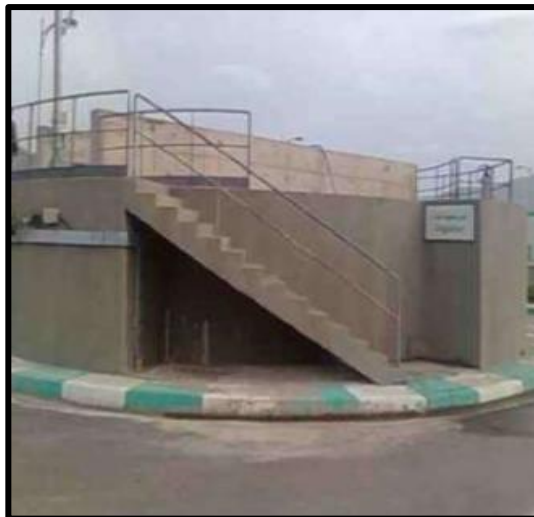
Figure 19 : dégazeur (STEP, Sidi Merouane).
