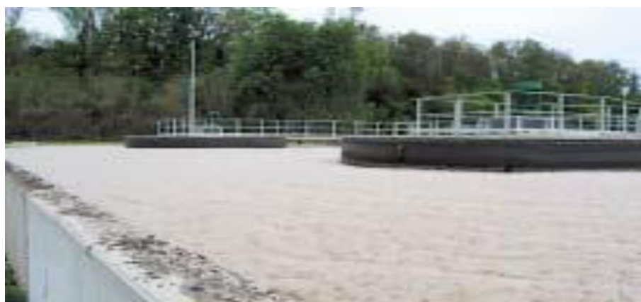
Figure 6 : Mousse biologique en surface d'un bassin d'aération ( BenfrehaBenyelles, 2022 ).
