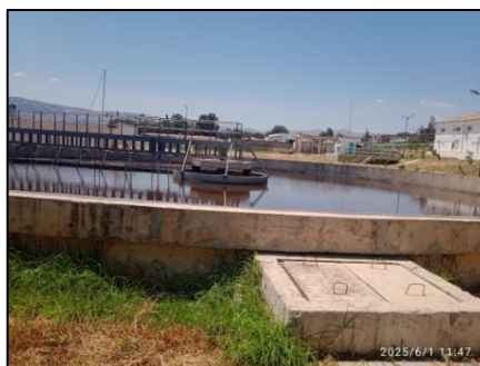
Figure 27 : Clarificateur (STEP, Ferdjioua).
