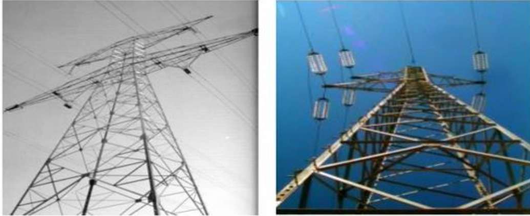
Figure IV-11 Photo de pylônes en acier.
