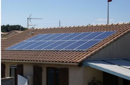
Panneaux photovoltaïques en toiture de maison
