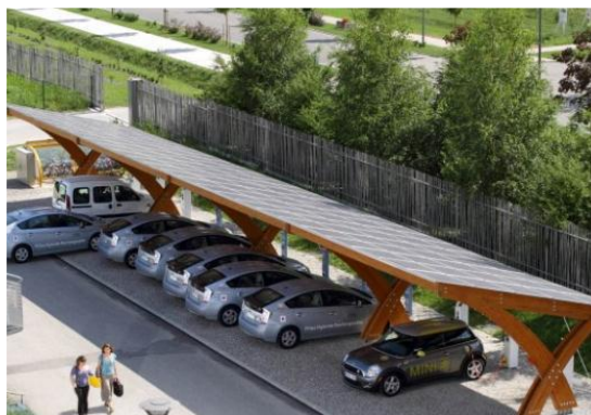
Parking solaire pour véhicules Electriques
