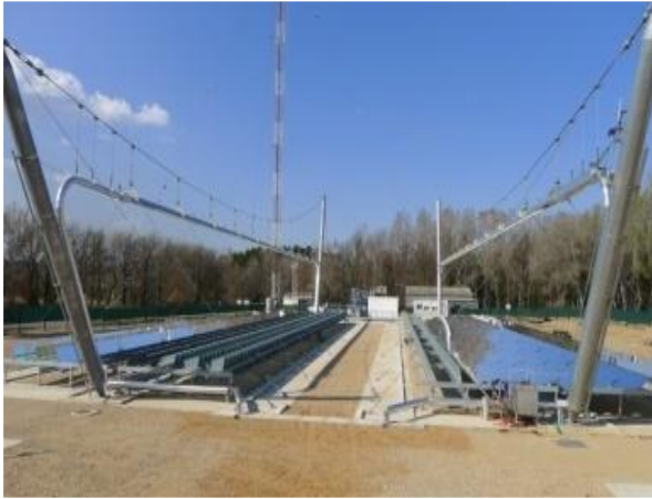
Centrale solaire à collecteurs de Fresnel
