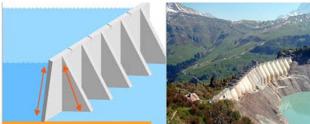
Figure IV-4 Le barrage de la Girotte, en Savoie.
