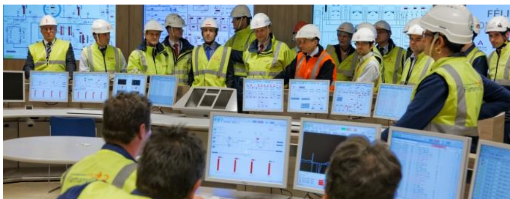
Figure III-1 Salle de commande du réacteur EPR de Flamaville – Copyright : MORIN ALEXIS
