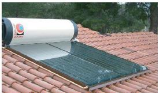
Photo : chauffe-eau solaire monobloc
