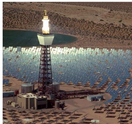
Récepteur à cavité d'une tour solaire
