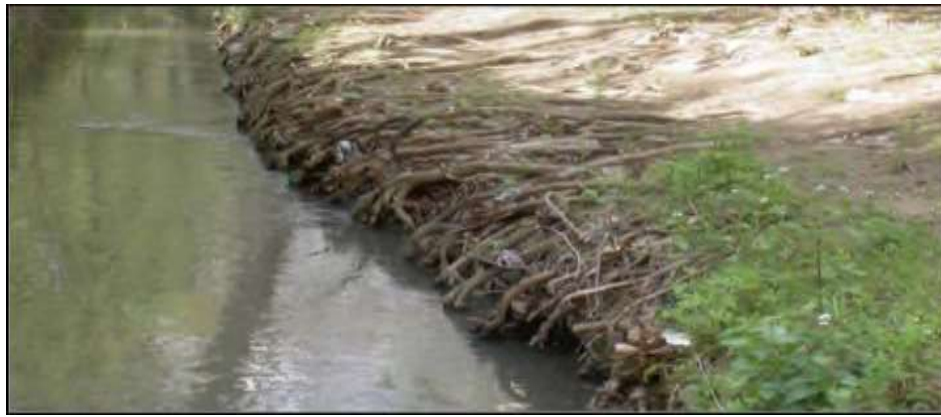
Figure 36 : Aménagement des berges de l’oued contre le glissement
