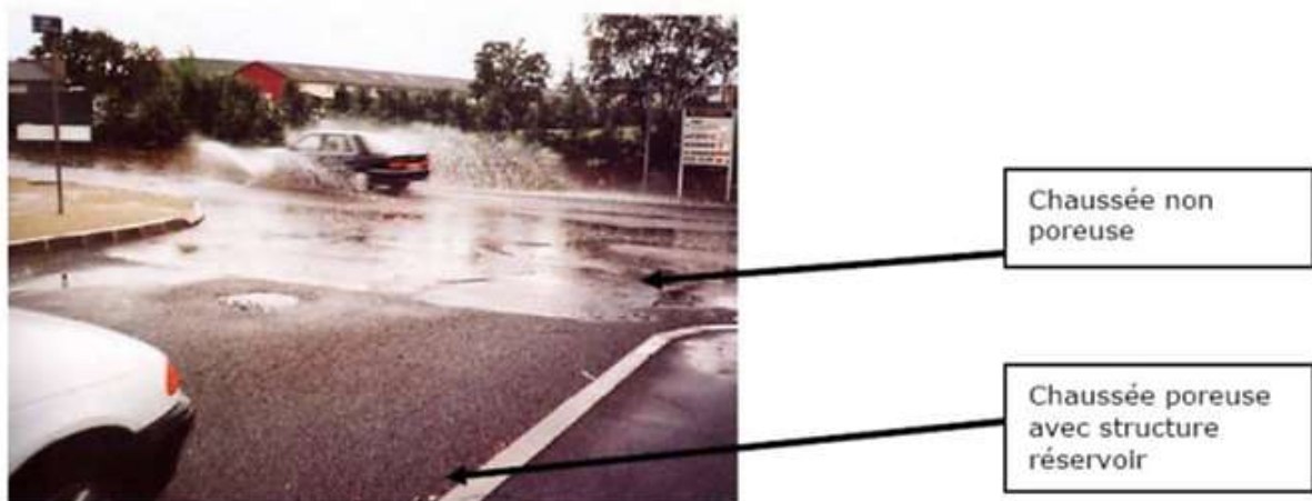
Figure 44 : Exemple d'aménagement de structures de stockage sous voirie alimentées par une bouche d'égout dans le cas de fortes pentes.
