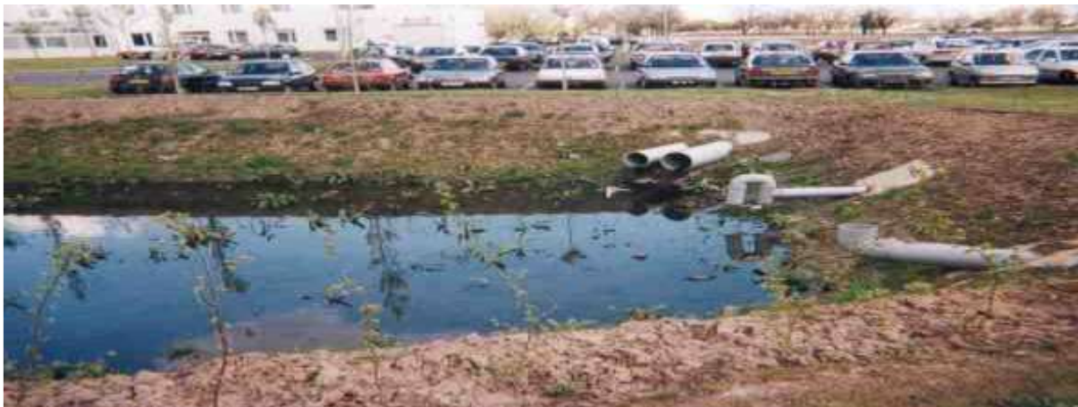
Figure 47 : Bassin à ciel ouvert en partie rempli après une averse
