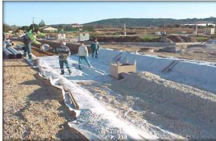
Préparation de la structure réservoir
