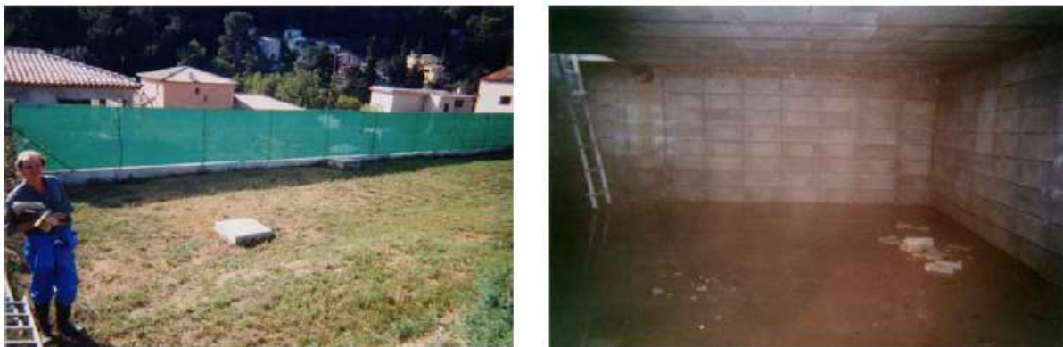
Figure 46 : A droite, un bassin de rétention enterré d'un immeuble d'un volume de 60 m 3 , à gauche un bassin enterré d'une villa de 25 m 3 .
