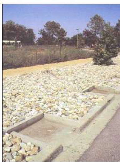
Tranchées le long de la voirie
