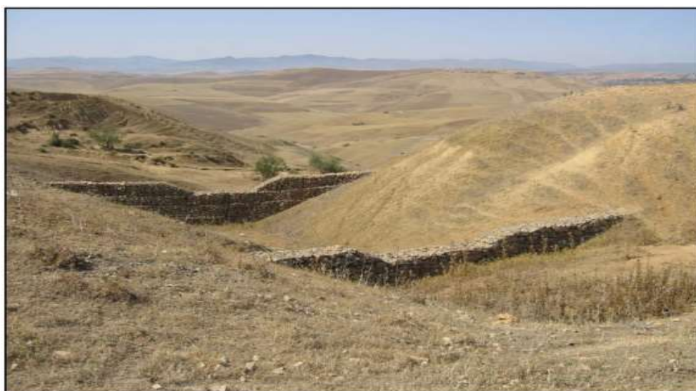
Figure 38 : Correction torrentielle dans la région de Tlemcen
