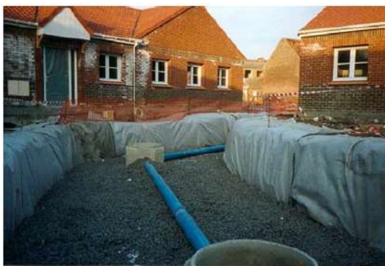
Figure 42 : Réalisation d'une tranchée drainante dans la ville de Lambre, France
