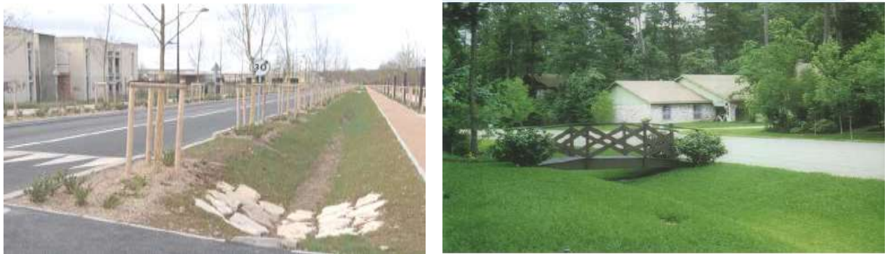
Figure 50 : Exemples d'aménagement de noues engazonnées et paysagères
