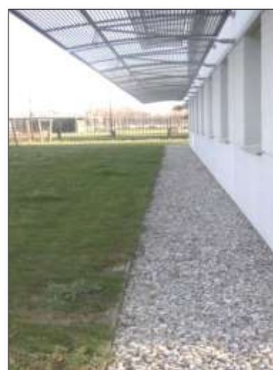
Tranchées sous toit
