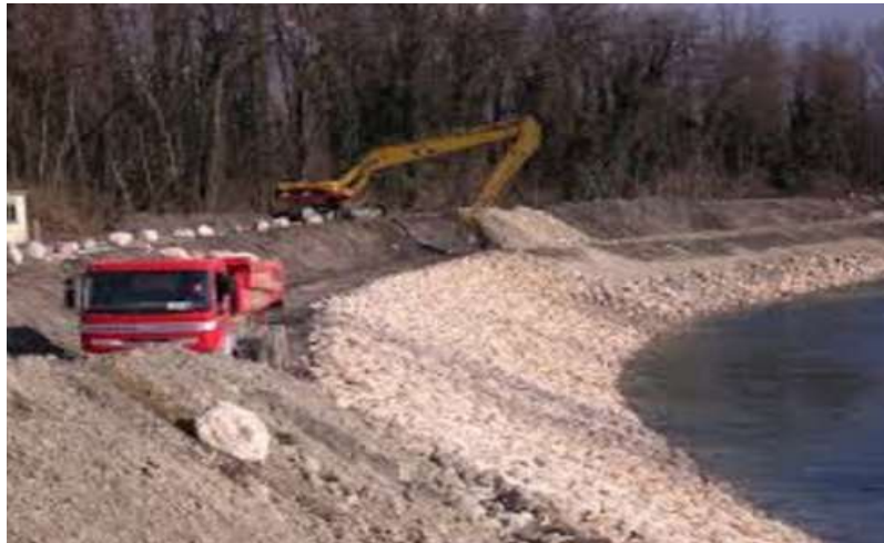
Figure 35 : Digue enroché
