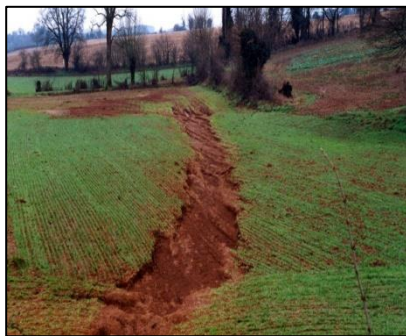
Erosion en nappe
