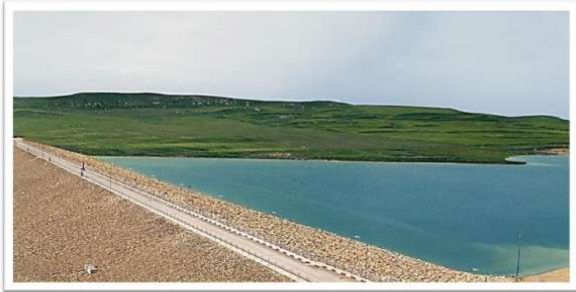
Figure18:Vue du Barrage Oued El Athmania . [30]
