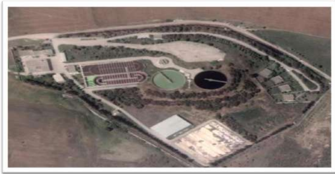
Figure22: Vue sur la station d'épuration des eaux usées Sidi Merouane . [43]
