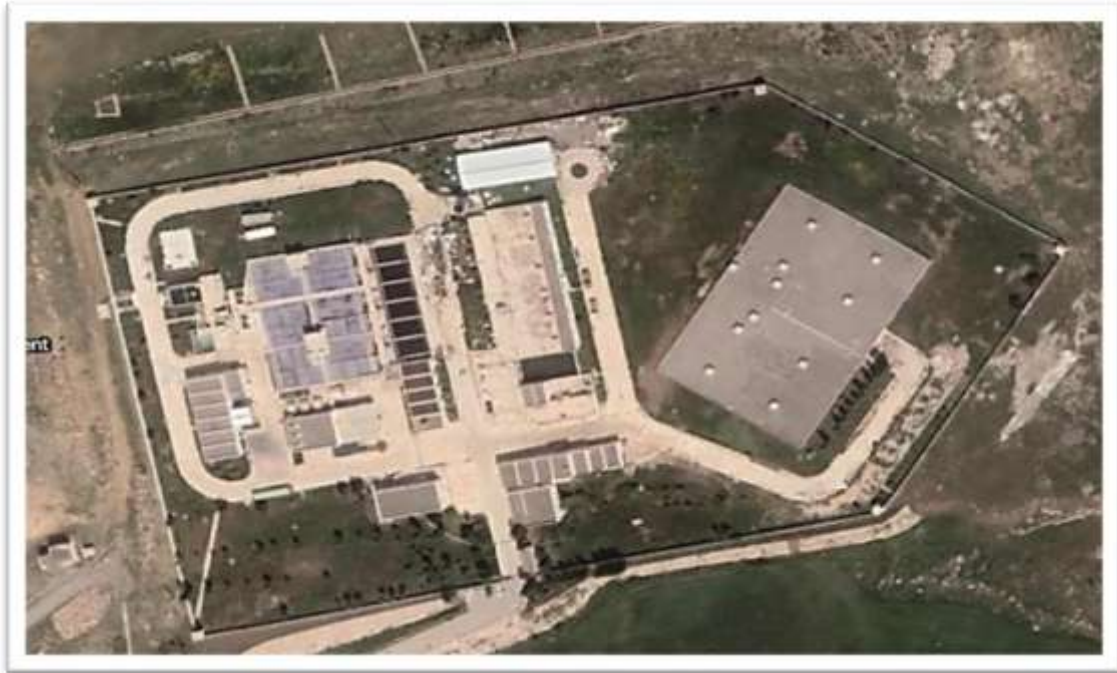
Figure20:Vue générale sur la station d'Ain tinn . [43]
