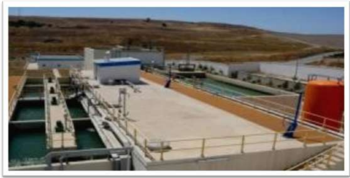
Figure21: Vue générale sur la station d'Oued Al Athmania. [44]
