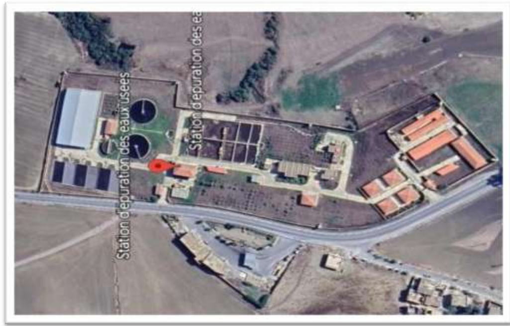
Figure 23: Vue générale sur la station de Ferdjoua. [43]
