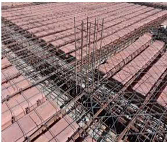
figure I- 10:Dalle à corps creux.
