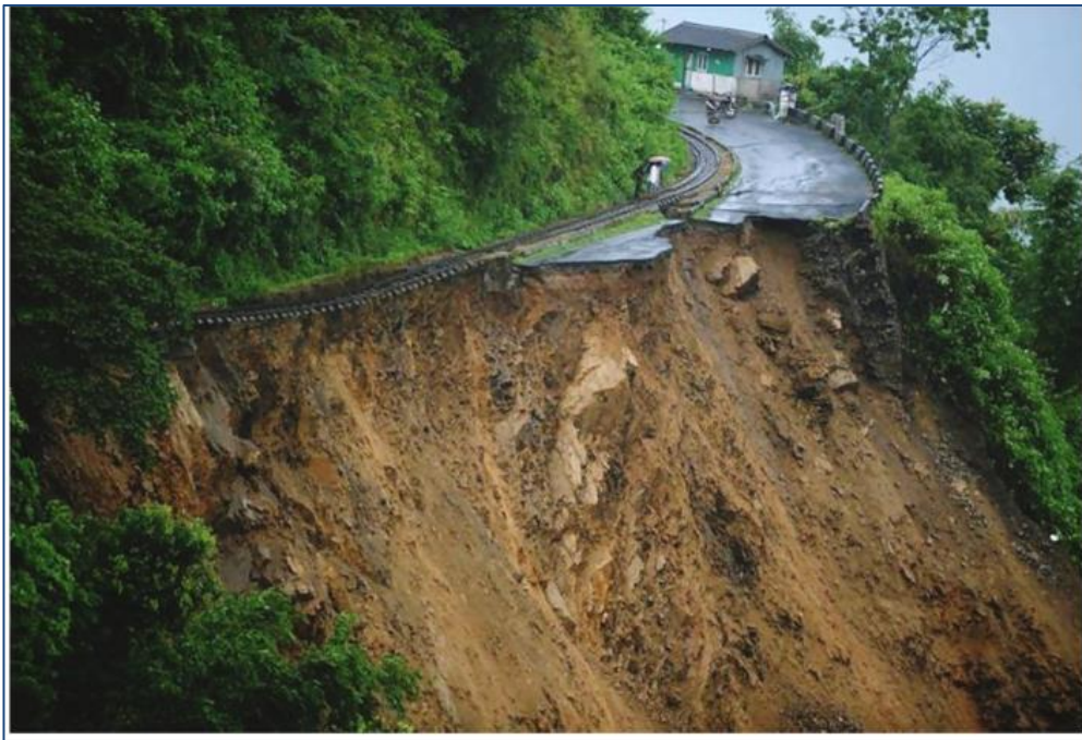
Figure I.8 : 2 ème cas de mouvement de terrain (glissement de terrain). [4]
