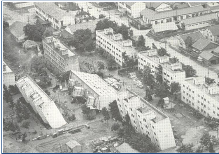
Figure I.6: Représentation du phénomène de liquéfaction des sols. [4]
