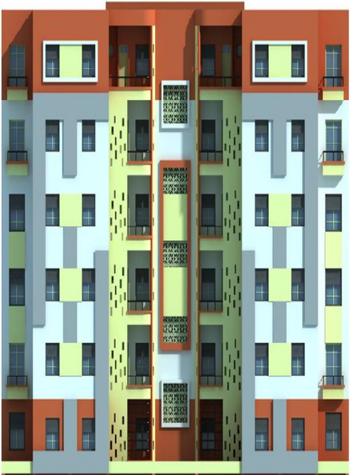
Figure I. 2: Vue de la façade postérieure du bâtiment.
