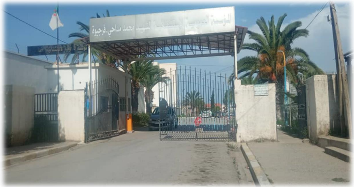
Figure 44 : Hôpital Mohamed Meddahi Ferdjioa.
