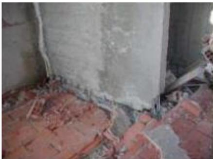
**Figure II.23:** Rupture de section à la base des voiles. [4]
