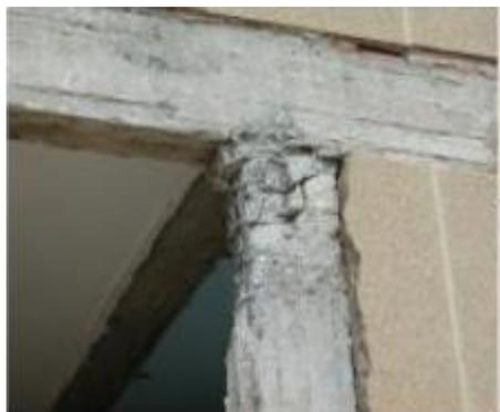
Figure II.14: Rotule dans le poteau (Comportement à éviter). [4]
