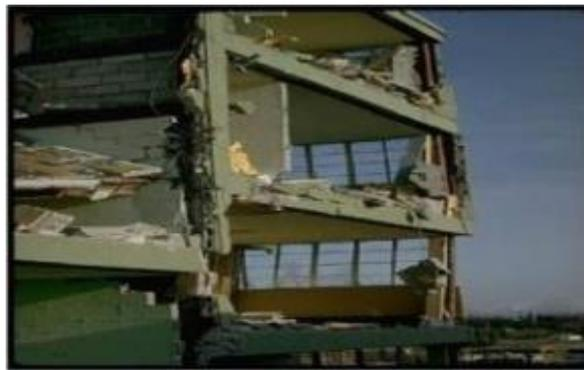
**Figure II.22:** Dislocation des remplissages de maçonnerie.[4]
