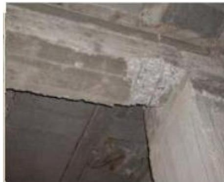
Figure II.15: Rotule dans la poutre (Comportement recherché). [4]
