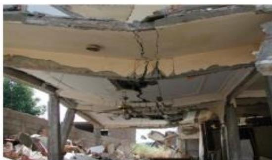
**Figure II.20:** Rupture par flexion des poutres. [4]
