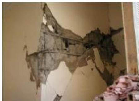
**Figure II.24:** Fissures ouvertes dans le voile. [4]
