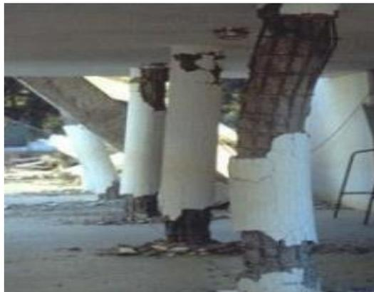
**Figure II.19:** Flambement des poteaux.[4]
