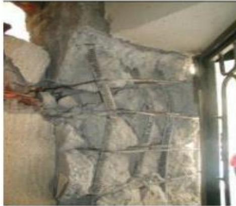
**Figure I.18:** Écrasement de béton et flambement des aciers dans les deux poteaux de la cage d'escaliers. [4]
