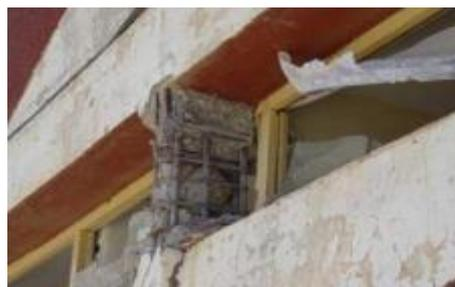
Figure I.17: Cisaillement d'un poteau court. [4]
