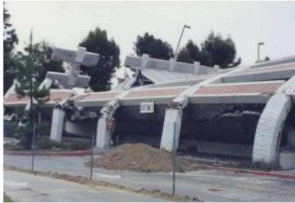
**Figure II.21:** Effondrement par flexion hors plan d'une structure portiques béton armé parking lors du séisme North bridge (Etats-Unis) en 1994. [4]
