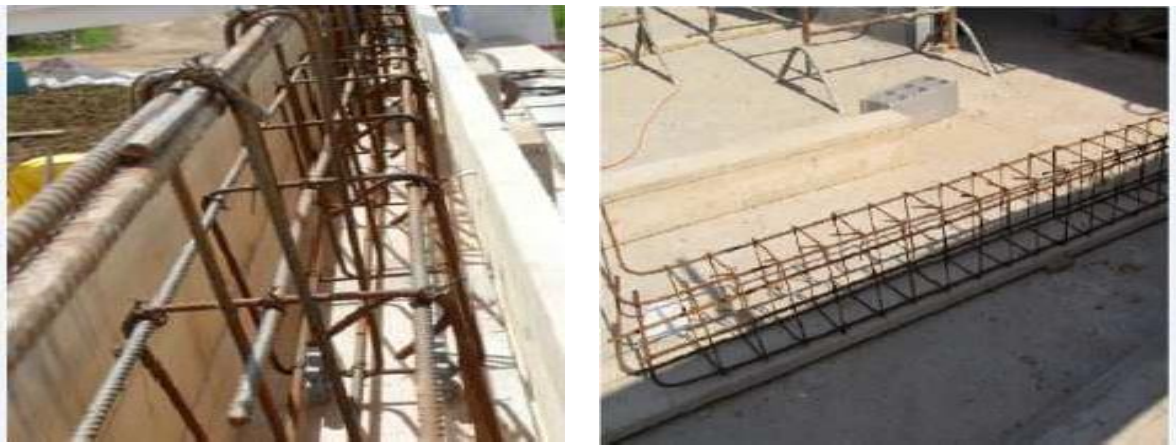
Figures VII.18 : ferrailage et coffrage de poutre
