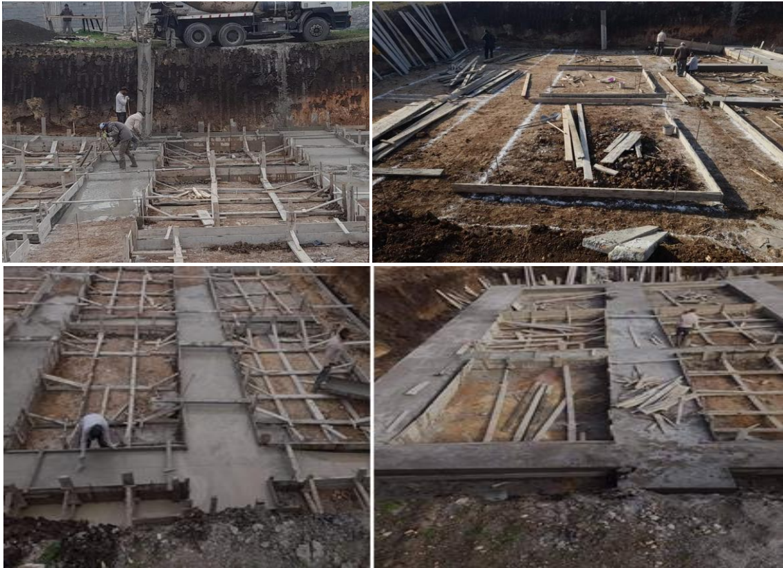
Figures VII.14: mise en place du béton de propreté
