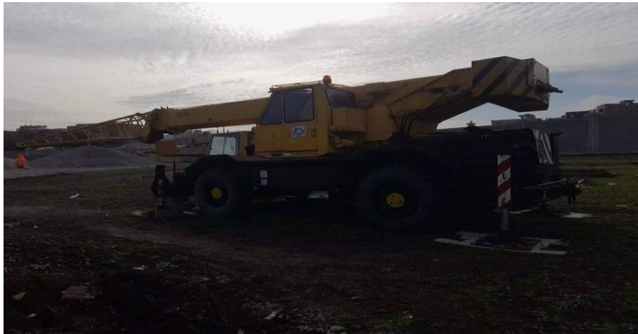
Figure.VII.3 : la grue mobile
