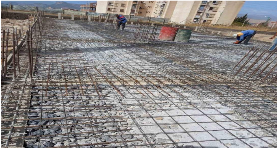
Figures VII.16: ferrailage de la dalle solidaire
