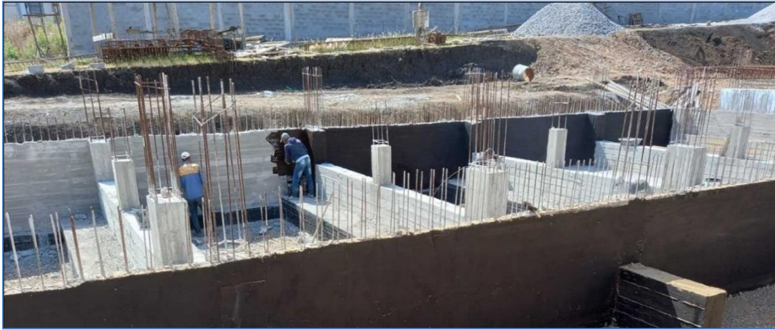
Figures VII.21 : décoffrage de la semelle filante
