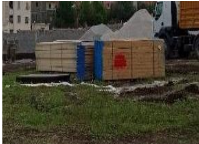
Figures VII.9: stockage du bois de coffrage
