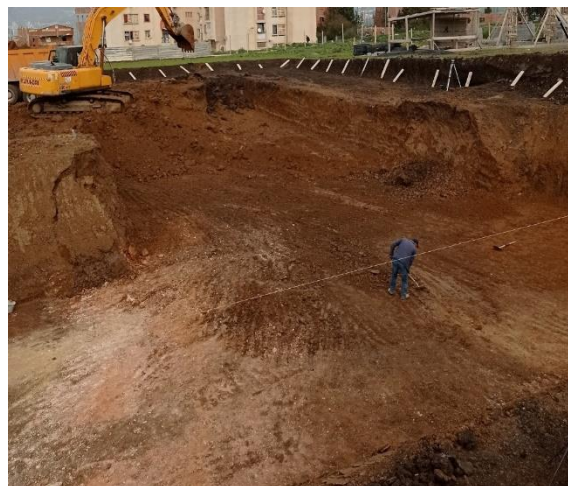
Figures VII.12: terrassement de terrain
