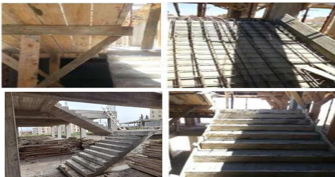
Figures VII.22: Coffrage, ferrailage et coulage d'escalier
