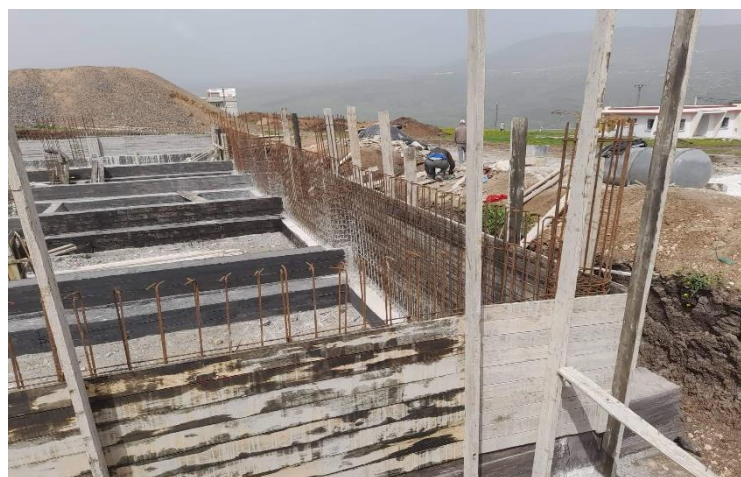
Figures VII.15: ferrailage et coffrage de voile périphérique
