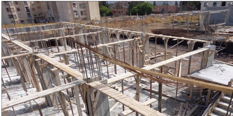
Figures VII.19 : coffrage en cours de plancher
