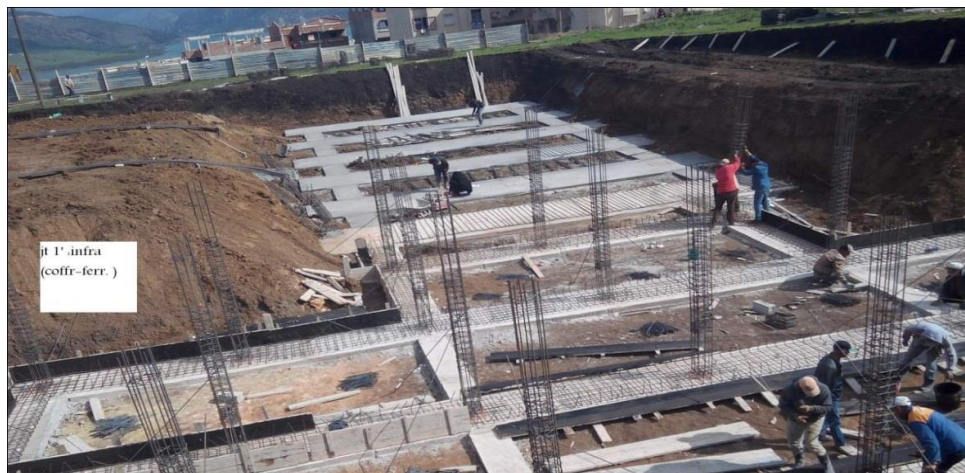
Figures VII.20 : ferrailage de la semelle filante
