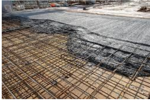
Figure I. 6 : Plancher en dalle pleine
