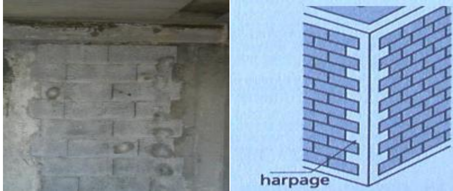
Fig. I.5 : La maçonnerie chaînée en harpage [11].
