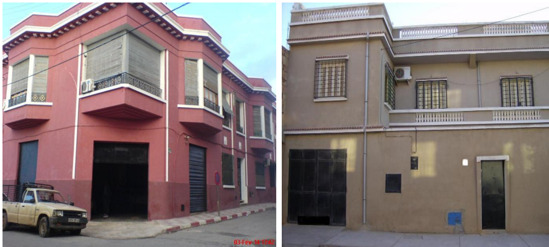
Fig. III.1 : Maisons d'habitation largement répandus en Algérie.
