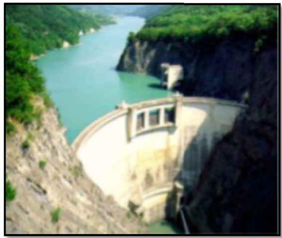
Figure I.6 : Exemple d'un barrage voûte (barrage de St-Pierre Cagnet)
