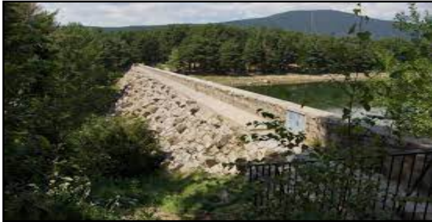
Figure I.14 : Barrage enrochement du monde entier
