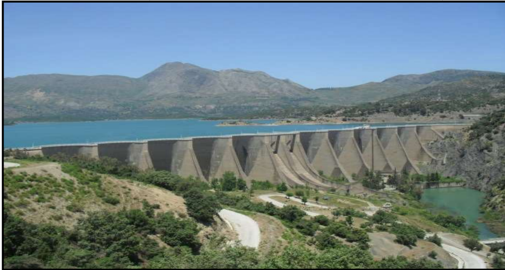
Figure I.15 : Les réserves de l'Algérie en eau de surface s'élèvent à 4 Mds m 3
