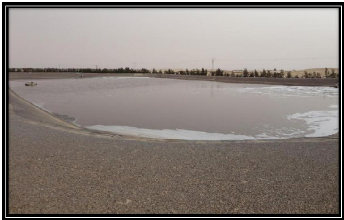
Figure III.8: Lagunes aérées (deuxième étape)
